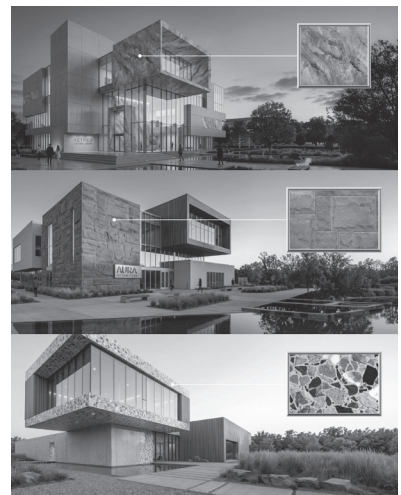
▲ 彩繪光電讓建築立面從被動包覆層升級為能源介面，兼顧城市景觀、品牌識別、防眩光與創能效益，是都會型建築與既有建築淨零轉型的重要路徑。
