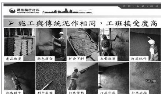
▲ 圖3 外牆塗抹節能隔熱材可達冬暖夏涼之效果（照片來源：潤泰精密材料提供）
