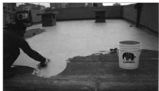
▲ 圖4 屋頂防水與隔熱塗料有效降低外殼熱負荷（照片來源：晶莊塗料提供）
