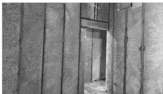
▲ 圖5 輕質玻璃陶粒預鑄版兼具預鑄與循環經濟材料特性（圖片來源：綠億綠建材提供）
