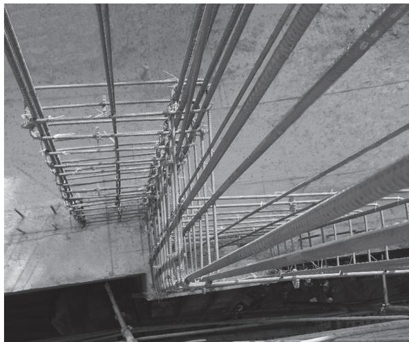
■ 目前採用 SRC 結構建案搭配國家發明金獎認證的「Alfa Safe 系統牆工法」，鋼筋間距整齊一致，防裂、防漏水且抗震韌性佳，業界使用後防水保固年限都拉長至 10 ~ 15 年。
