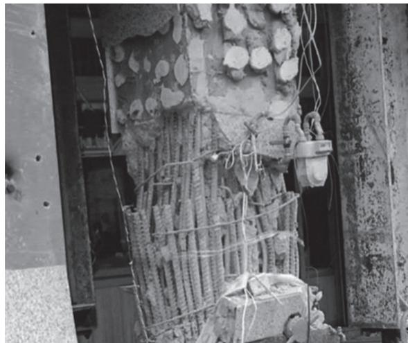
■ 當設計鋼筋間距太小時，石粒被卡住無法隨拌合體自由流動，就會造成混凝土無法充分包裹鋼筋，這樣鋼筋就無法發揮結構設計上所須達到的強度效果。
