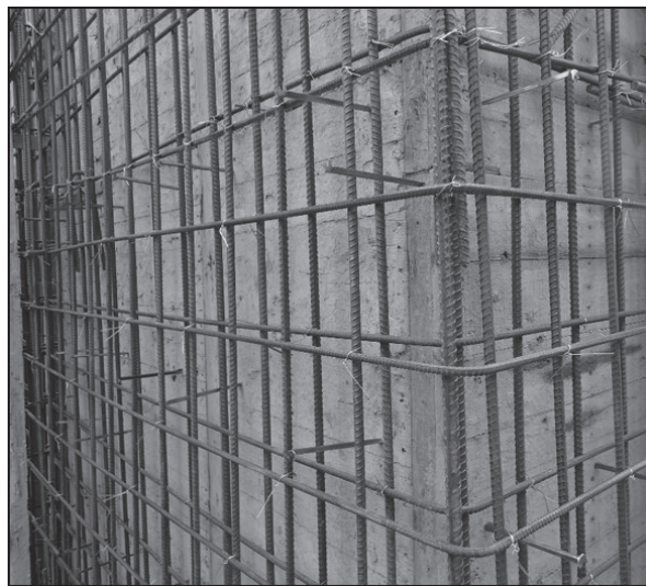
▲系統化工法一體式箍筋綁紮，輕鬆組裝；施工品質控制精準，牆鋼筋轉角完全封閉圍束，與傳統牆相比抗震韌性提升 33%，有效防裂防漏水。
