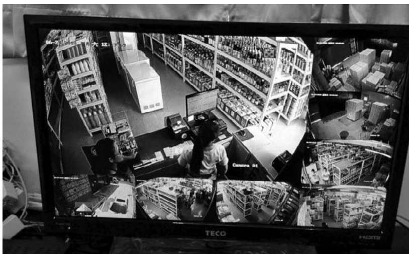
▲ 學員傅先生監控系統安裝實際情況。
